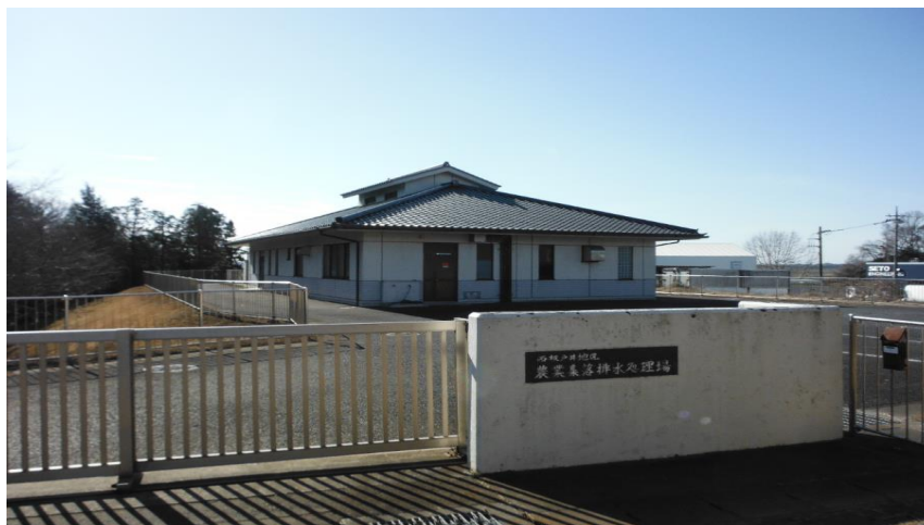
西板戸井地区 農業集落排水処理場
