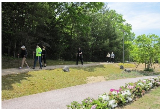
④遊び場を囲む、再生瓦チップ舗装を施した約300mのウォーキングコース。幅広い年齢層の利用を呼び込む
