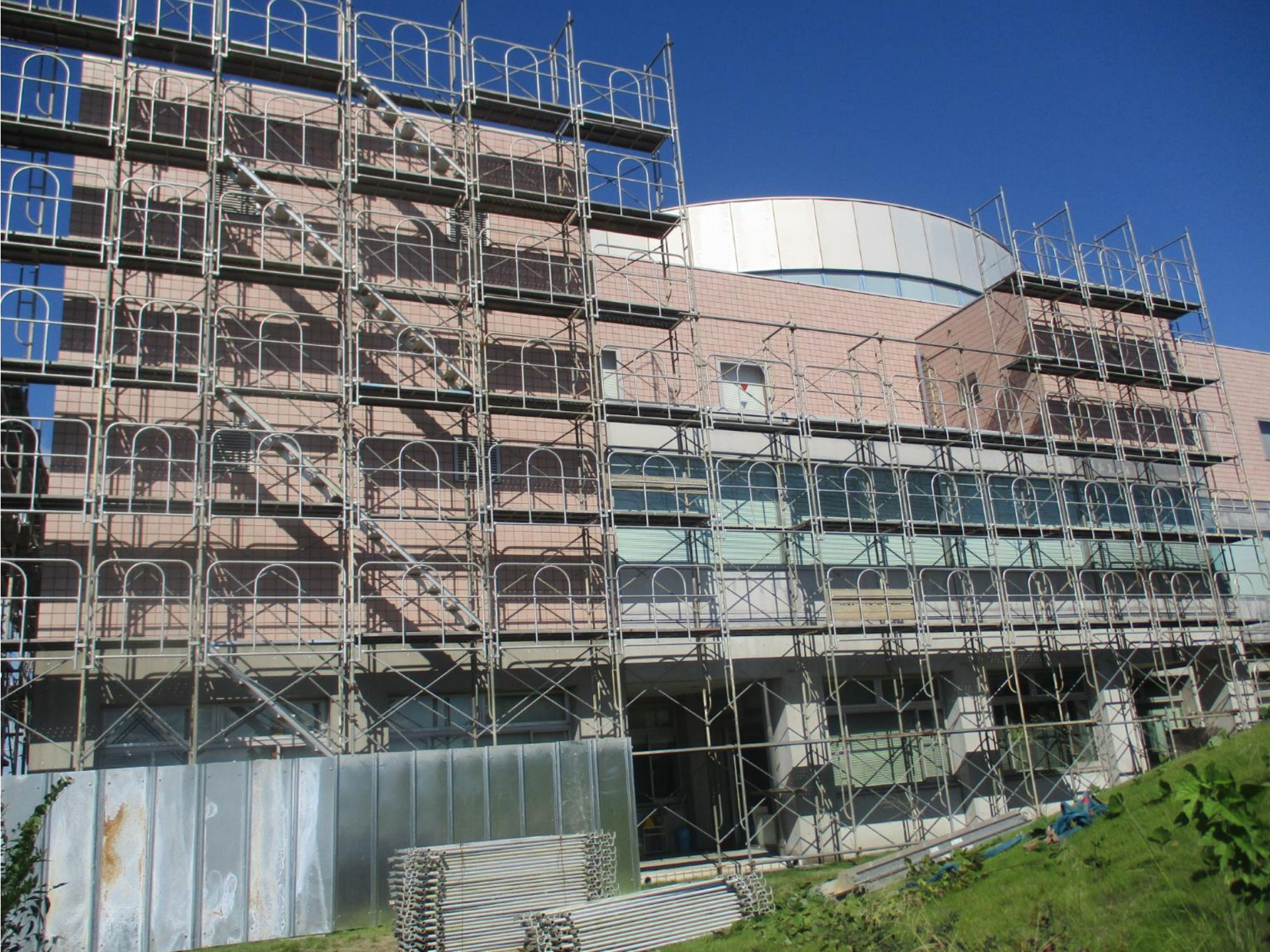
市役所駐車場 側 仮囲い・足場 作業
