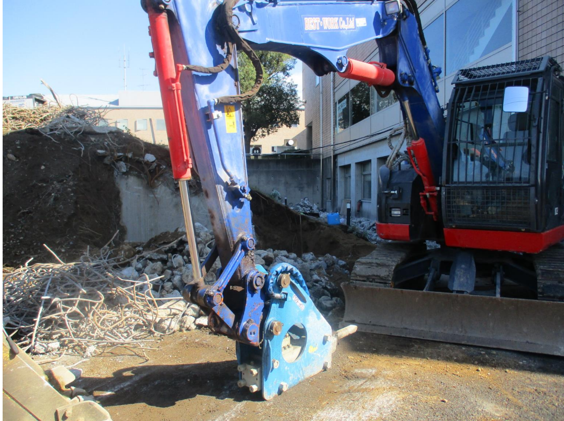
職員駐車場 擁壁解体
