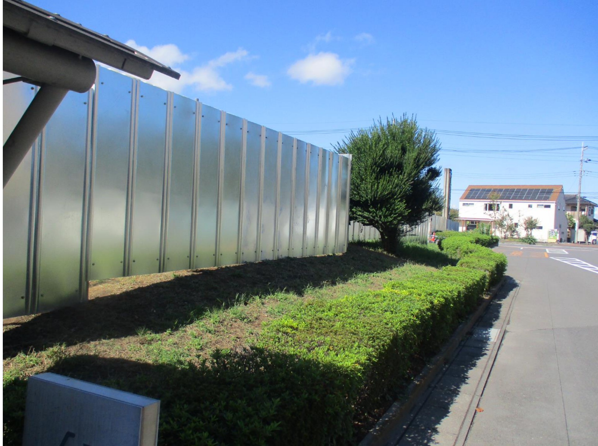
市役所側 仮囲い
