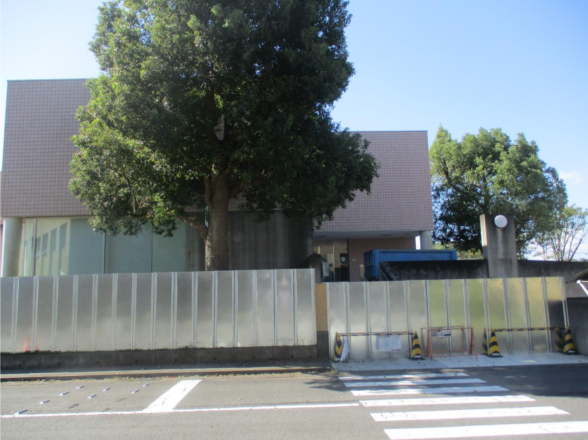
正面玄関 仮囲い
