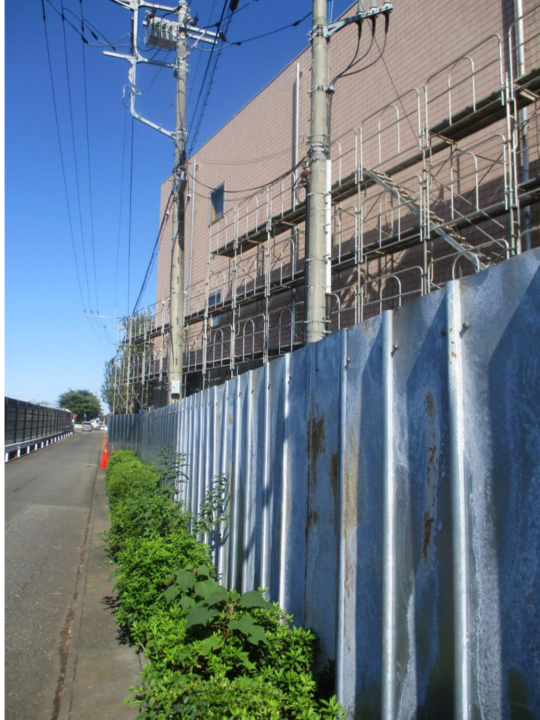
高速道路側 1 仮囲い・足場作業
