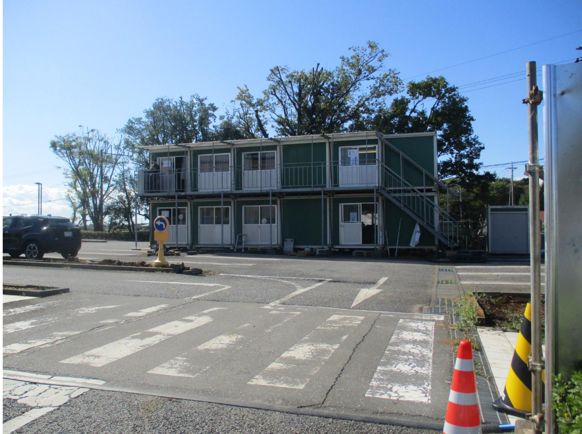
駐車場 現場事務所
